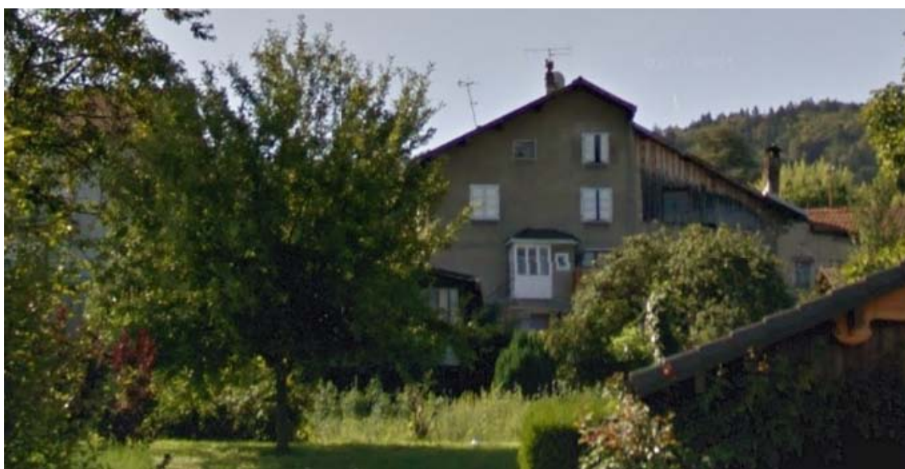
Espace naturel (vide)_vue depuis chemin des Oiseaux_limite Nord de l'OAP1
